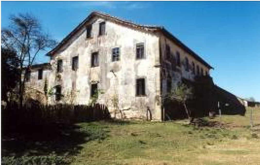
Figura 12. Sobrado da fazenda Vista Alegre. Fachada oeste: ornamentação simplificada. Foto: Benincasa, 2003.
