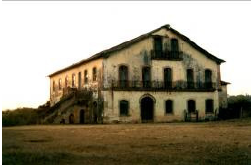
Figura 7. Sobrado da fazenda Vista Alegre. Fachada sul. Foto: Benincasa, 2003.
