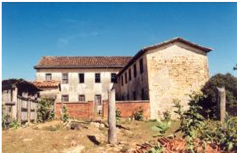
Figura 8. Sobrado da fazenda Vista Alegre. Fachada leste: fundos. Foto: Benincasa, 2003.
