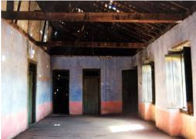
Figura 13. Interior do sobrado: sala de jantar. Foto: Benincasa, 2003.
