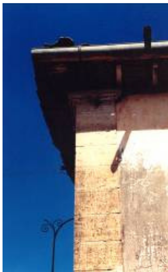
Figura 9. Sobrado da fazenda Vista Alegre. Detalhe do cunhal em pedra lavrada. Foto: Benincasa, 2003.
