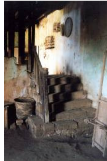
Figura 14. Interior do sobrado: cozinha "suja", no térreo. Foto: Benincasa, 2003.
