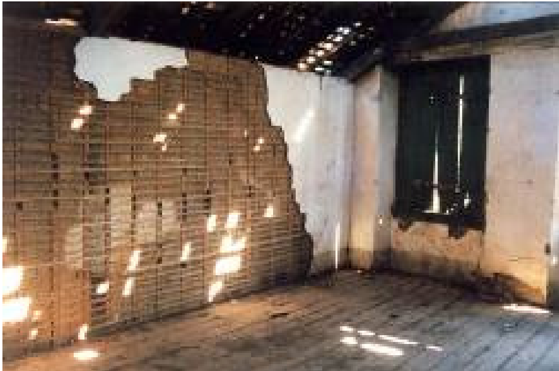
Figura 20. Interior do sobrado, sôto: pode ser visto a estrutura de madeira preenchida com barro. Foto: Benincasa,
