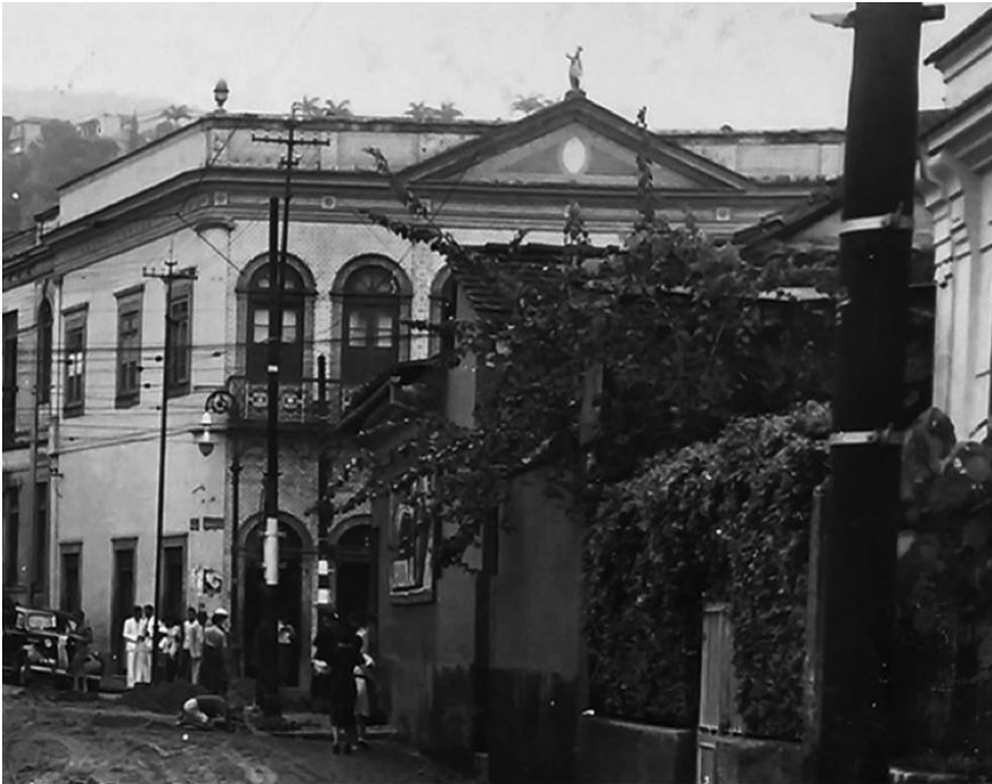
Fig.5. Prédio da rua Riachuelo, 1854. Fonte: < http://azulejosantigosrj.blogspot.com/2012/09/lapa-i-rua-riachuelo.html >.
