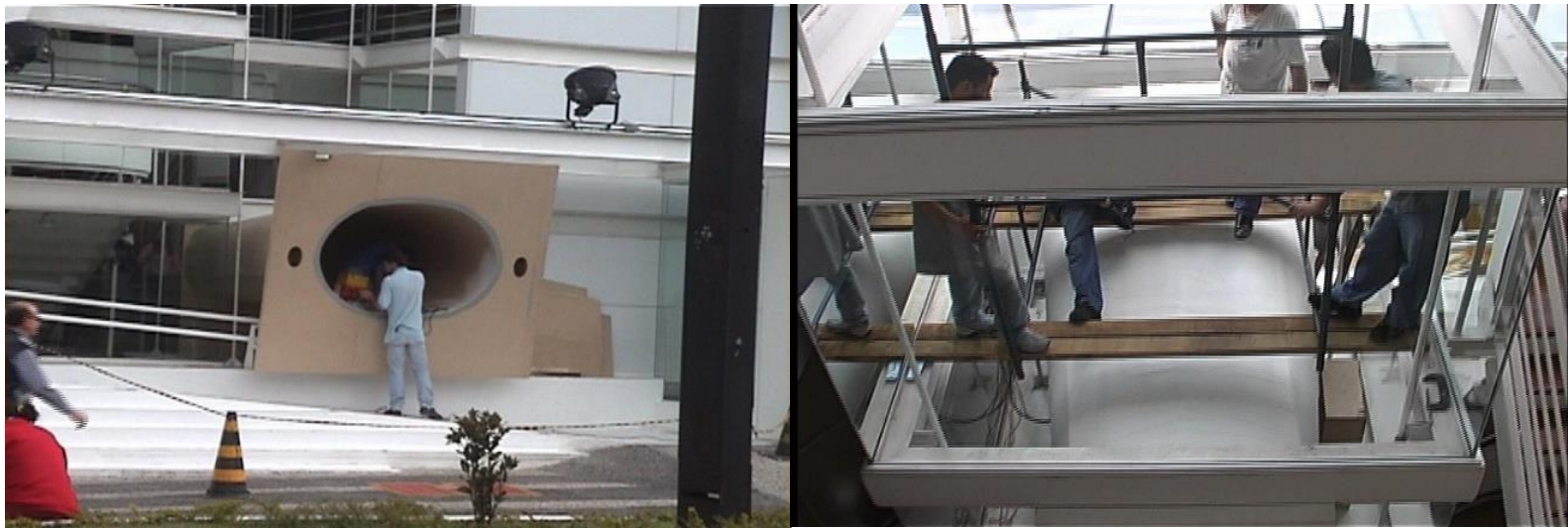
Figs. 7 e 8. Montagem da estrutura na fachada do IC (esquerda); vista interior mostrando equipe instalando a estrutura no vão de vidro (direita). Arquivo da artista.
