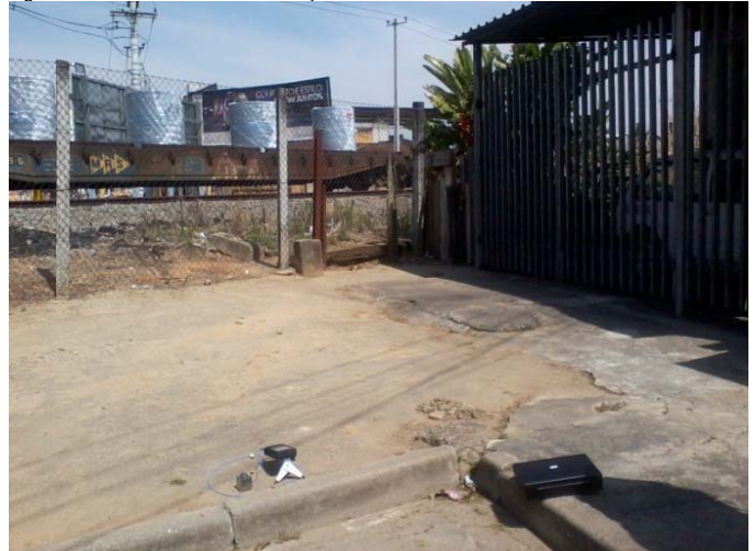
Figura 4. Sistema de medição apoiado diretamente no solo
