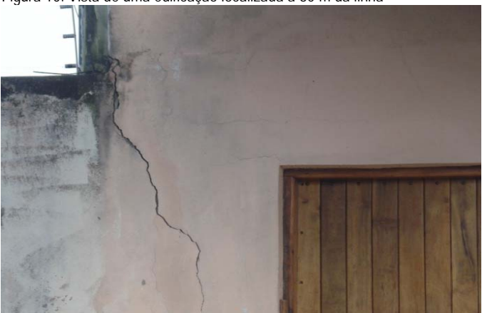
Figura 10. Vista de uma edificação localizada a 30 m da linha
