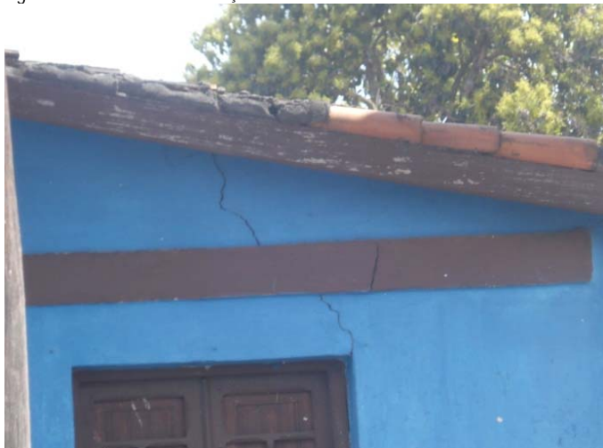
Figura 9. Vista de uma edificação localizada a 10 m da linha
