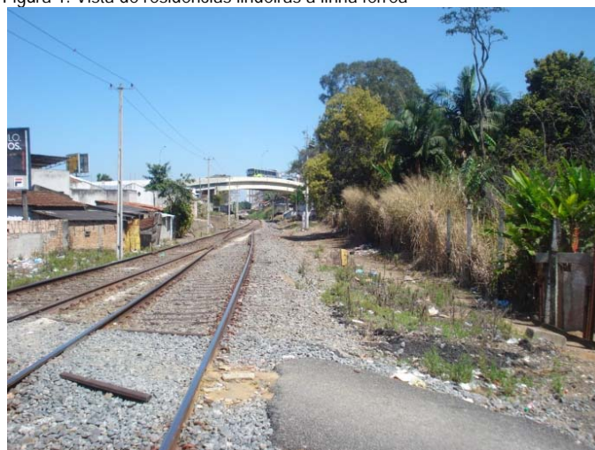
Figura 1. Vista de residências lindeiras a linha férrea
