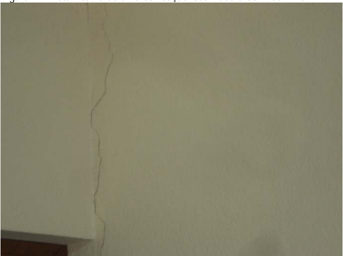
Figura 11. Vista interna de uma edificação localizada a 50 m da linha
