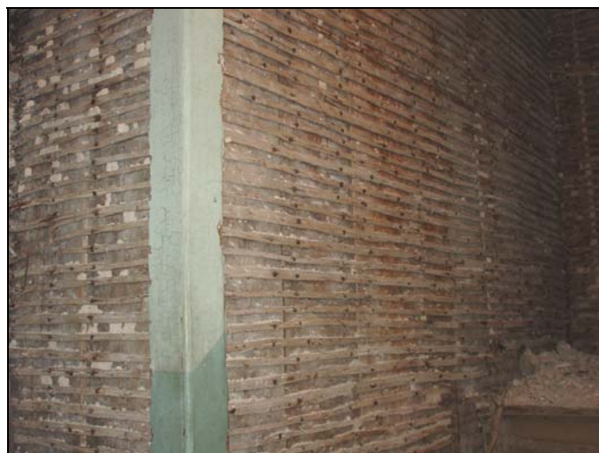
Figura 10. Parede divisória em tabique.
