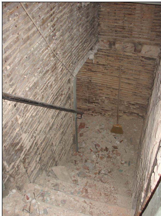
Figura 8. Técnica construtiva utilizada na escada.
