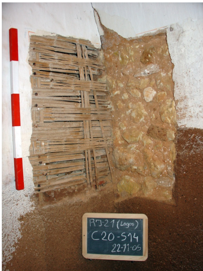
Figura 14. Sondagem efectuada no interior do edifício.
