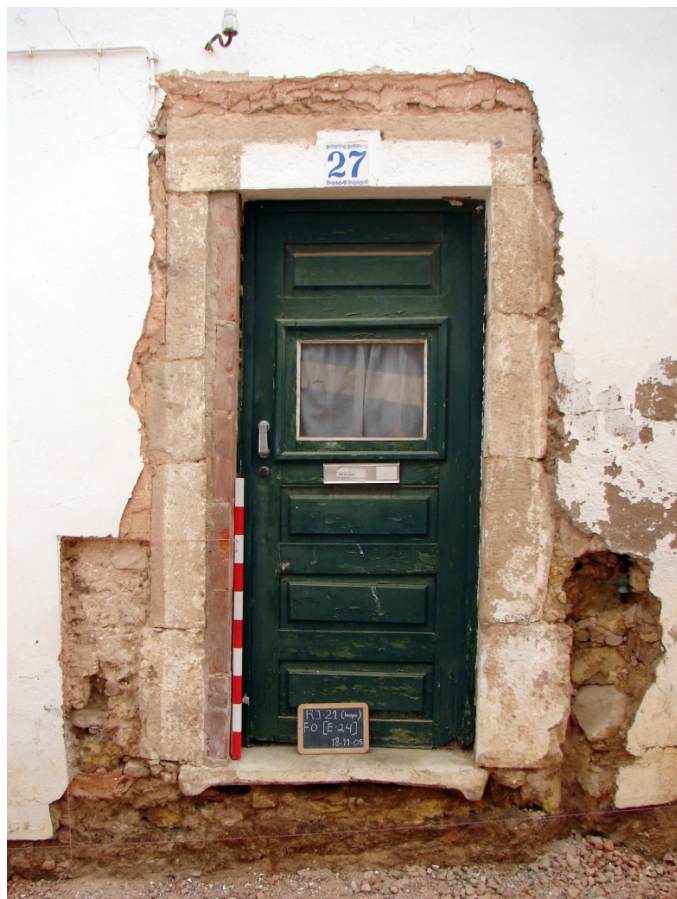
Figura 12. Sondagem efectuada no exterior do edifício.
