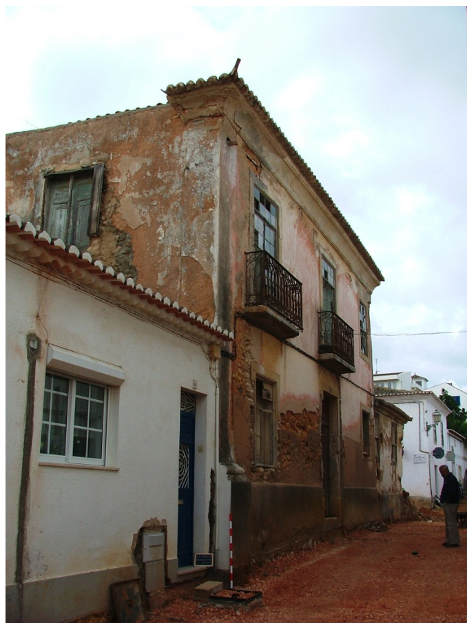
Figura 11. Fachada principal do edifício sito na Rua do Jardim, nº 21.
