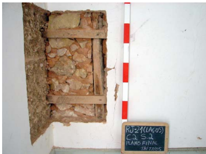
Figura 13. Sondagem efectuada no interior do edifício.
