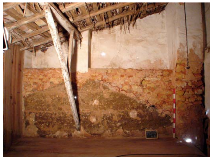
Figura 15. Sondagem efectuada no interior do edifício.
