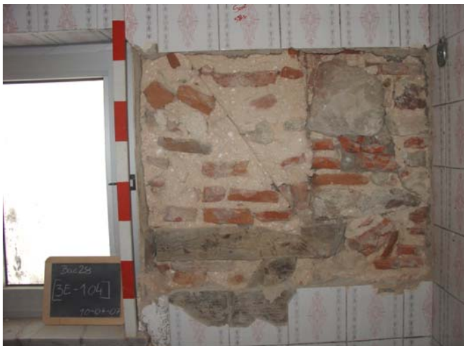
Figura 3. Sondagem parietal efectuada no 2º Andar.
