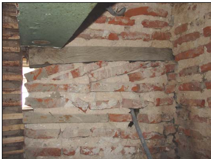
Figura 6. Pormenor da chaminé.
