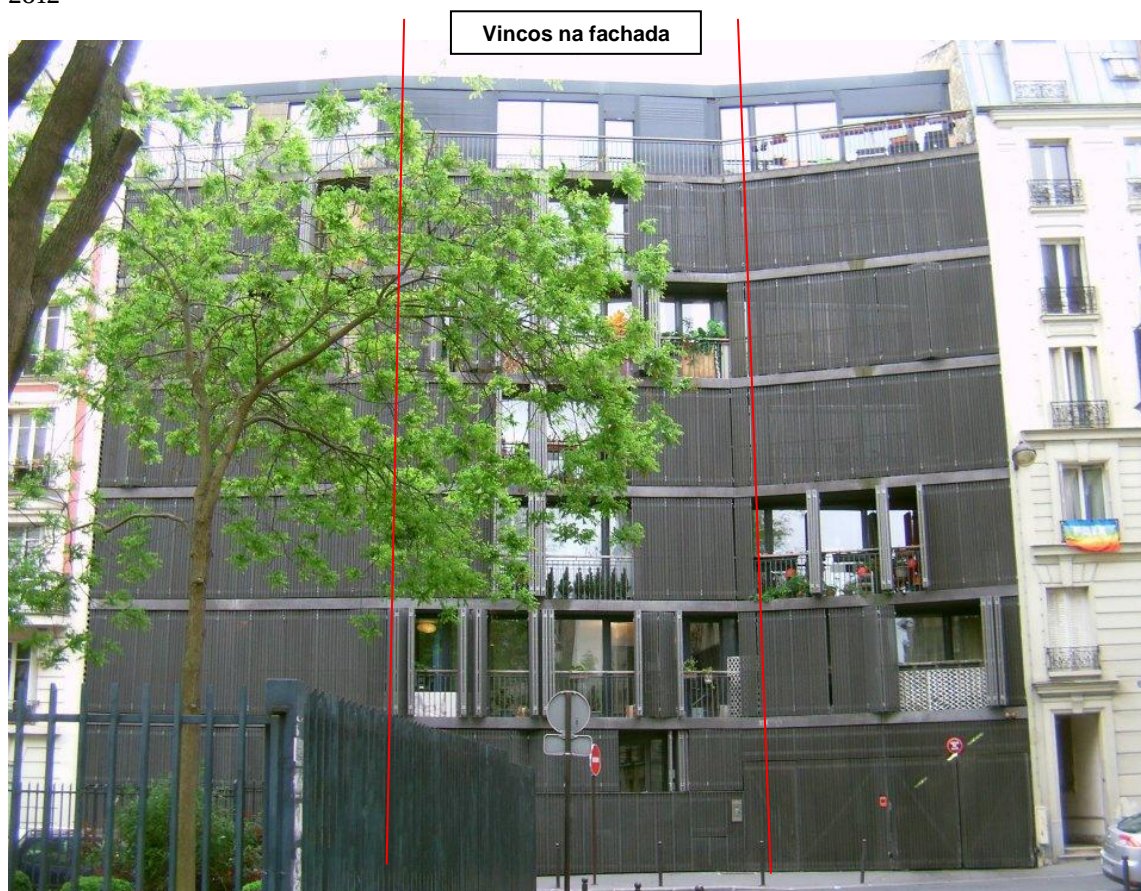
Figura 6 - Fachada Rue des Suisses - Fonte: Fotografia de Aline Uara, 2012
