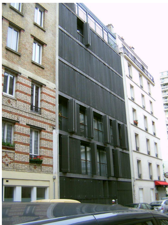
Figura 8 - Fachada Rue Junquoy - Fonte: Fotografia de Aline Uara, 2010
