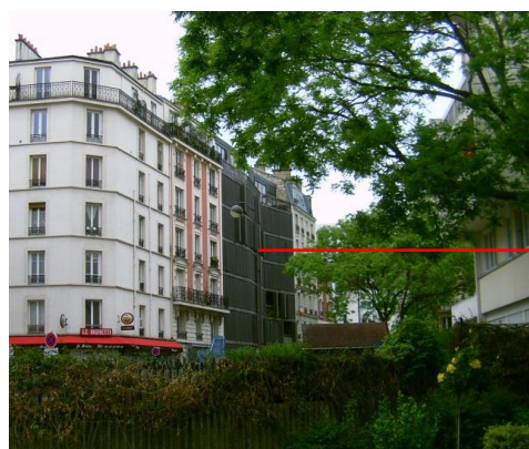
Figura 5: Edifício A - Fotografia de Aline Uara, 2012
