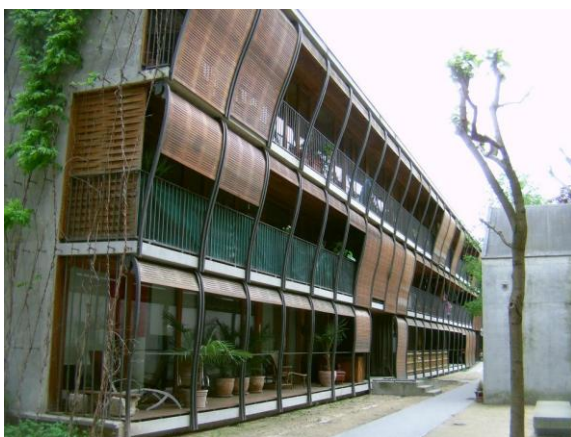
Figura 11 – Blocos C e D - Fonte: Fotografia de Aline Uara, 2012
