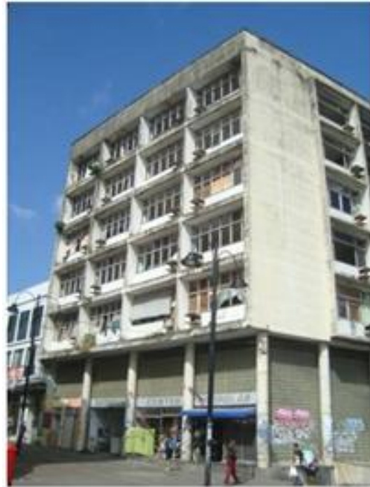
FIGURA 2: Edifício IPASE – Volumetria e Fachada leste.
