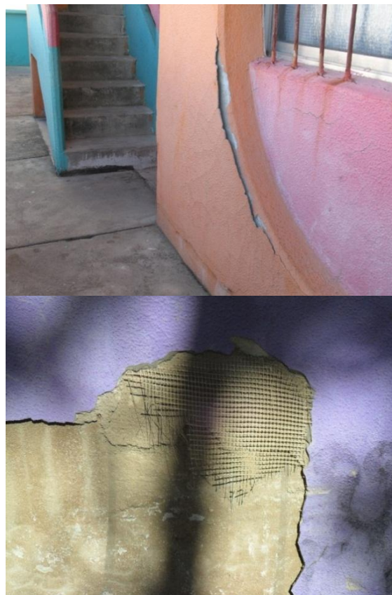
FIGURA 5 - Bairro do Condado: Zona J ; Patologias em paredes. (Fotografias dos autores).
