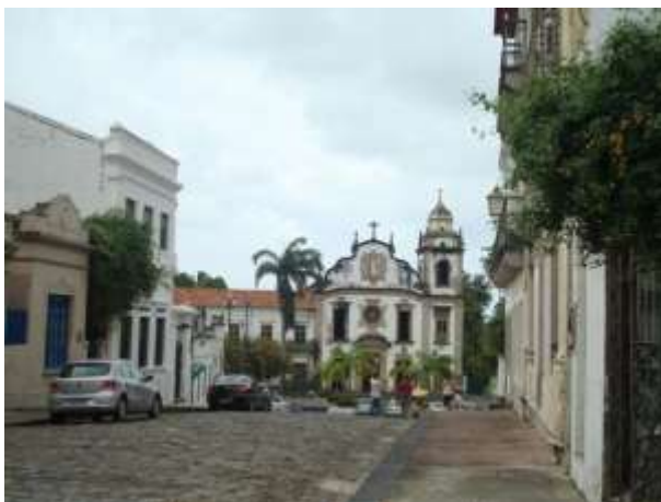
FIGURA 8: Mosteiro de São Bento em Olinda na ZEPC1. Patrimônio da Humanidade. Nota-se a falta de conservação da fachada. Fonte: Levantamento próprio, 2009.
