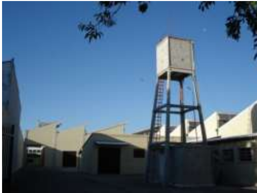
FIGURA 26 – Reforma no exterior da casa noturna Pacha.
