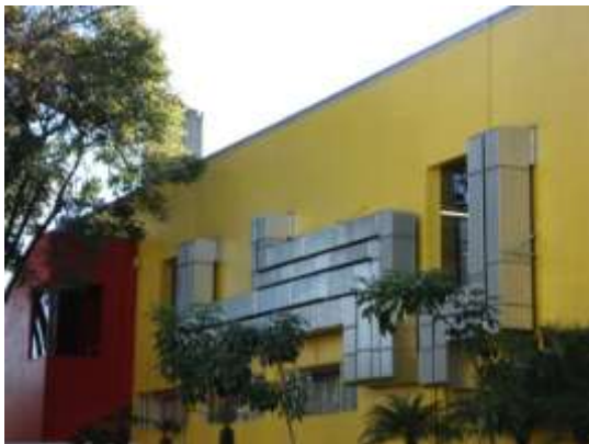
FIGURA 28 – O sistema de ventilação da Agência Neogama remetendo à arquitetura fabril.
