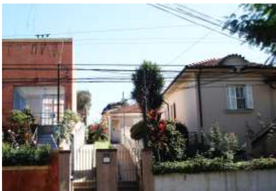
FIGURA 01 – Fachada das Casas na Vila. FONTE: Geise B. Pasquotto, 2007.
