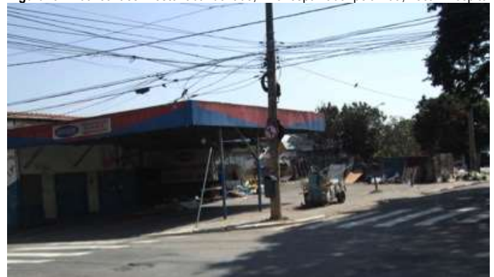
Figura 9: Rua Javaés Posto abandonado, lixo espalhado pela rua, local inóspito
