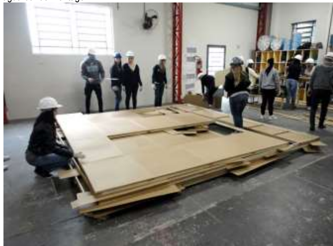
Figura 5. Painéis de madeira revestidos com papelão e empilhados sobre o piso, aguardando montagem.
