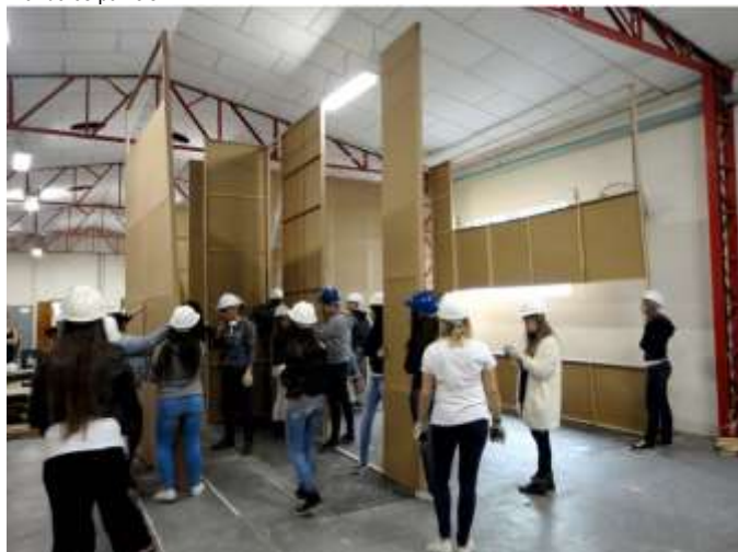
Figura 7. Sequência de imagens da montagem do mesmo mock-up . Manobrando e fixando os painéis.
