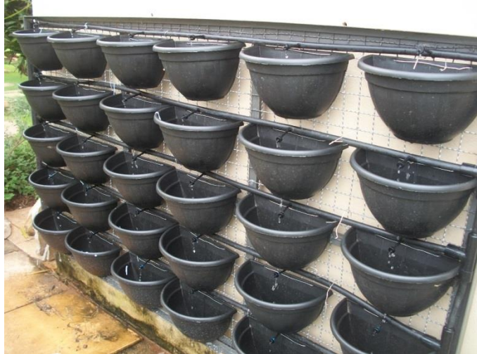
Figura 7. Sistema de irrigação por gotejamento em Parede Viva de Vasos.
