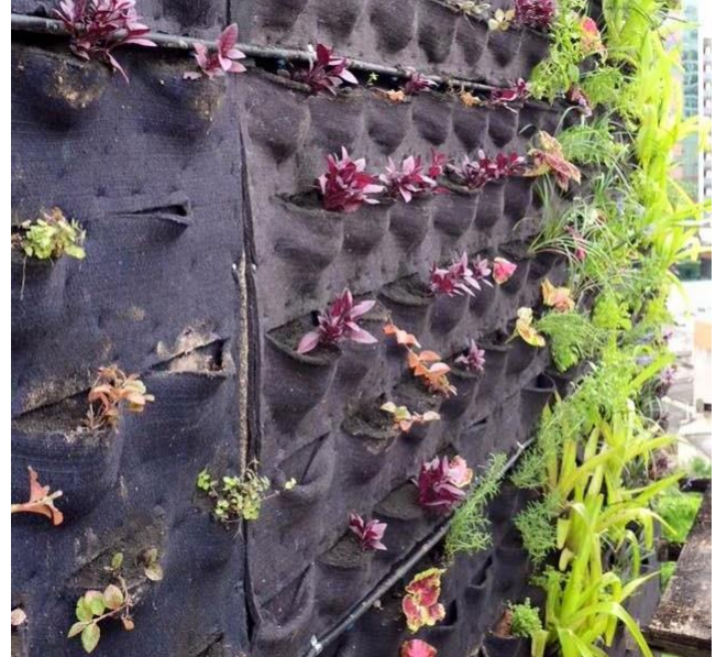
Figura 5. Parede Viva Contínua em Feltro. Detalhe para as bolsas moldadas na primeira camada do feltro.
