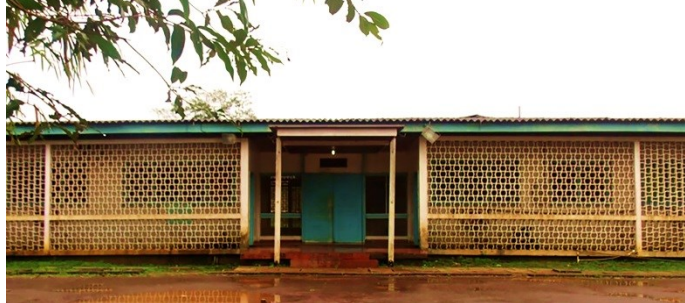
Figura 9 – Hospital da Vila Serra do Navio
