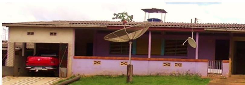
Habitação da Vila BC com ampliação em alvenaria para construção de garagem e de pátio frontal com mureta
