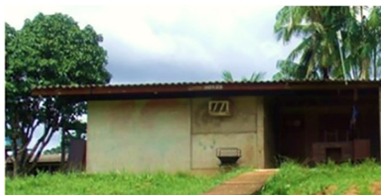
Habitação da Vila BC apresentando vedação da janela com alvenaria e aplicação de caixa de ar no local
