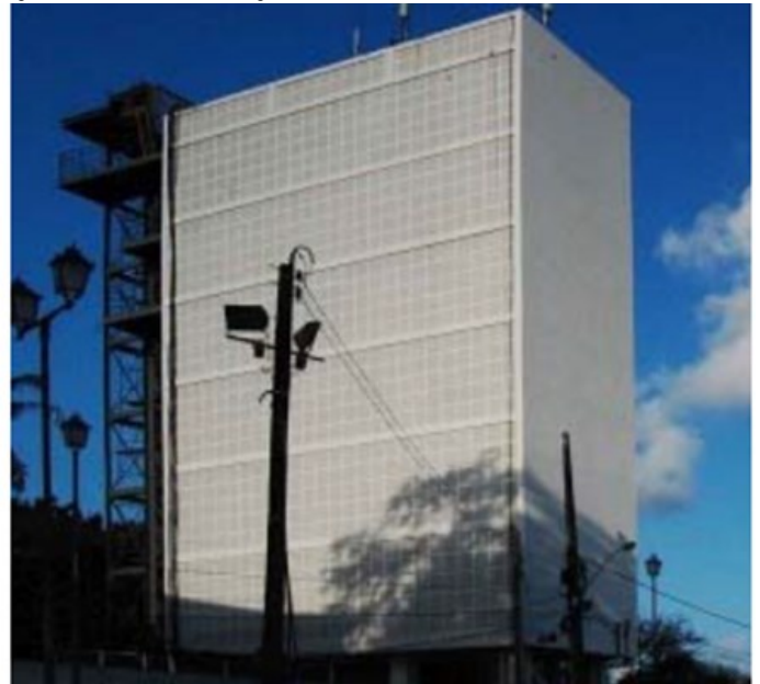
Figura 12 - Edificio Caixa d’ Agua, 1935
