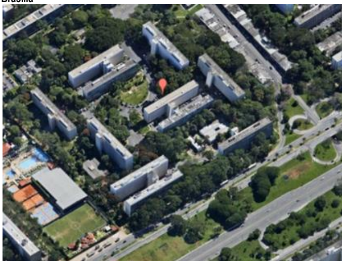
Figura 1 - Situação geográfica do edifício na superquadra do Plano Piloto de Brasília
