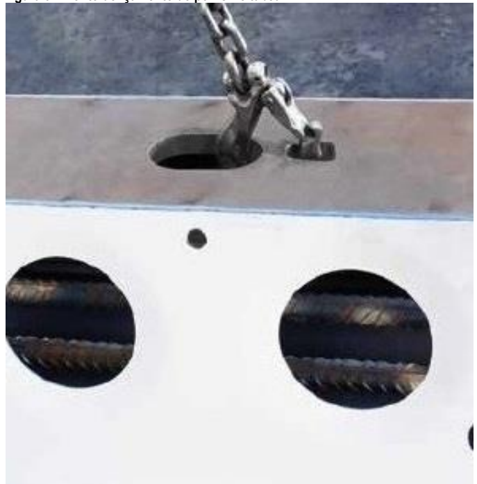
Figura 9 - Ponto de içamento de perfis Deltabeam®
