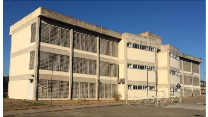
Figura 14 – Edifício AT-7 (UFSCar)
