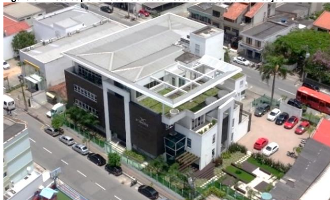
Figura 5 - Vista superior das fachadas Leste e Norte da edificação
