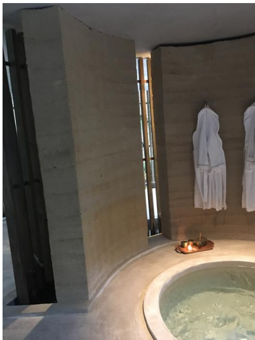
Figura 3 – Uso contemporâneo da taipa de pilão em ambiente da CASACOR Rio de Janeiro-RJ 2018
