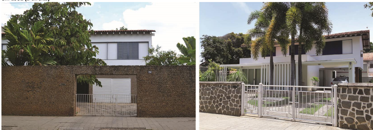
Figura 5 – Residência Francisco Inácio Peixoto projetada por Niemeyer em 1941 (à esquerda) e Residência Altamiro Peixoto, projetada por Telles em 1952 (à direita)
