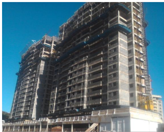
Figura 1 – Edifício residencial durante construção
