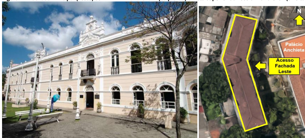
Figura 2 – Fachada Principal (Leste) da “EEEFM Maria Ortiz” (esquerda) e vista superior da Escola Maria Ortiz (direita)
