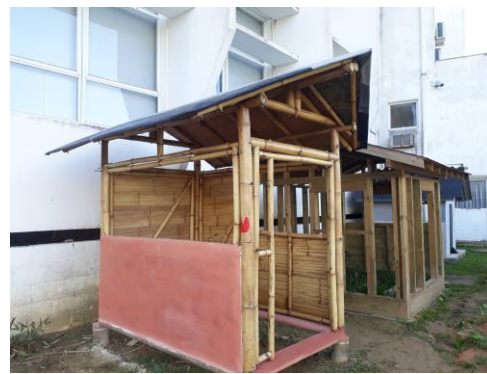
(C) Protótipo em Bambu revestido em terra
