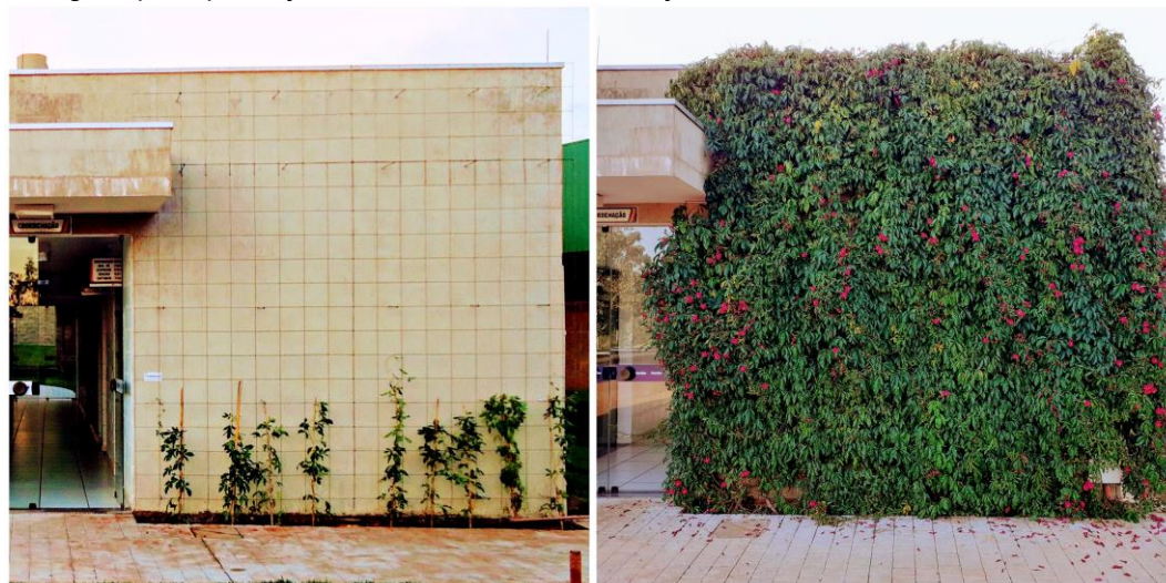
Figura 6 - Foto do experimento com fachada verde: (esquerda) apresenta a situação da Fachada verde no momento da montagem e (direita) a situação da fachada verde na fase das medições das variáveis microclimáticas
