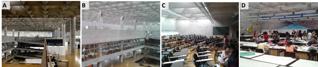
Figura 4 – (A) Vista interna do Salão Caramelo com o efeito luminoso das claraboias originais de fibra de vidro degradadas. (B) Vista interna do interior do edifício, Salão Caramelo, com o bloco da biblioteca com aberturas para o vazio central. Destaque para o efeito luminoso criado pelas novas claraboias de acrílico. (C) Vista de uma das salas de aula (sala 812), após a reforma da cobertura e a troca das claraboias. (D) Vista de um dos estúdios, com o efeito das novas claraboias
