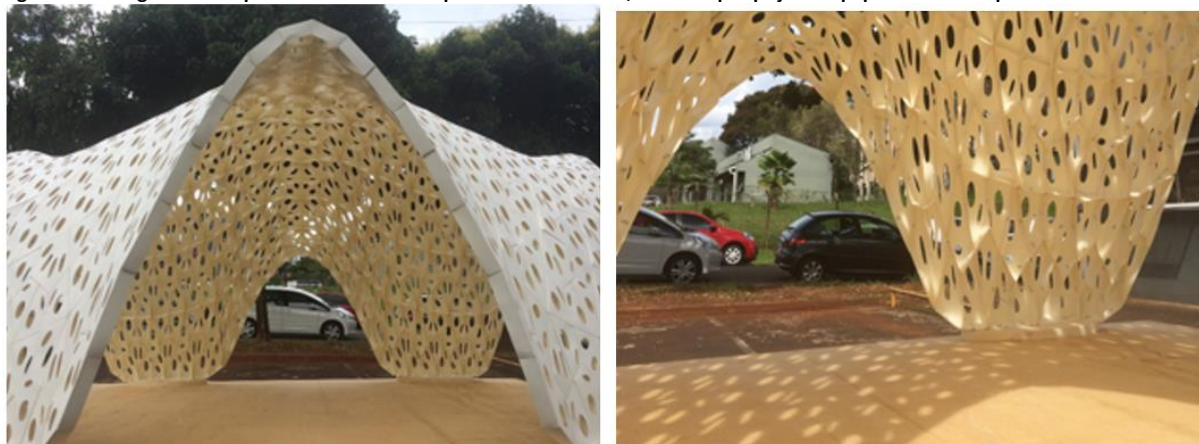
Figura 11 – Imagens da maquete da forma livre experimental montada, formada por peças em papel cortado na plotadora de recorte
