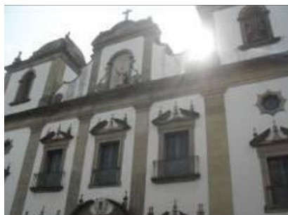
Fig. 08: Fachada Frontal da Igreja da Madre de Deus. Fonte: Vanessa Rodrigues, 2014.
