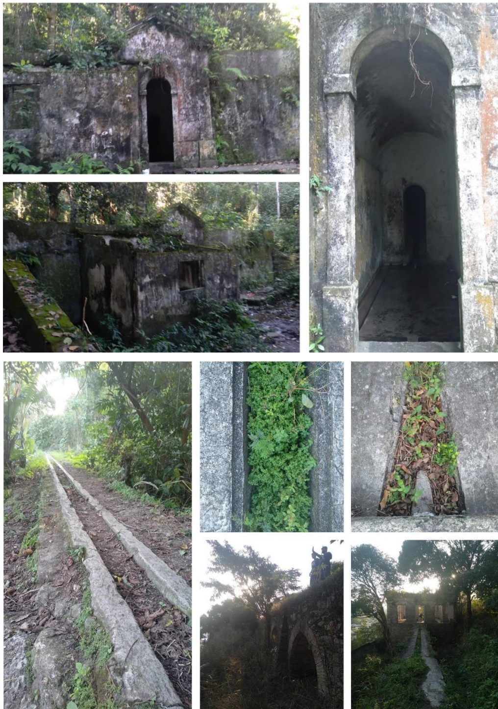
Figura 8 – Superior: Fachada da cisterna B – Inferior: Canal superficial
