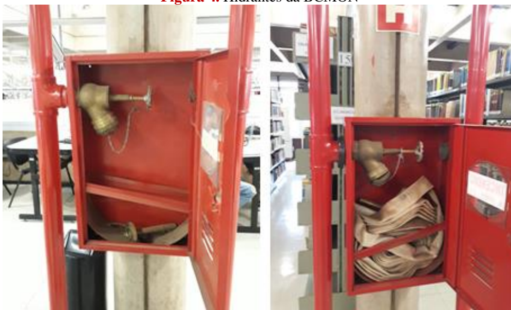
Figura 4. Hidrantes da BCMON
