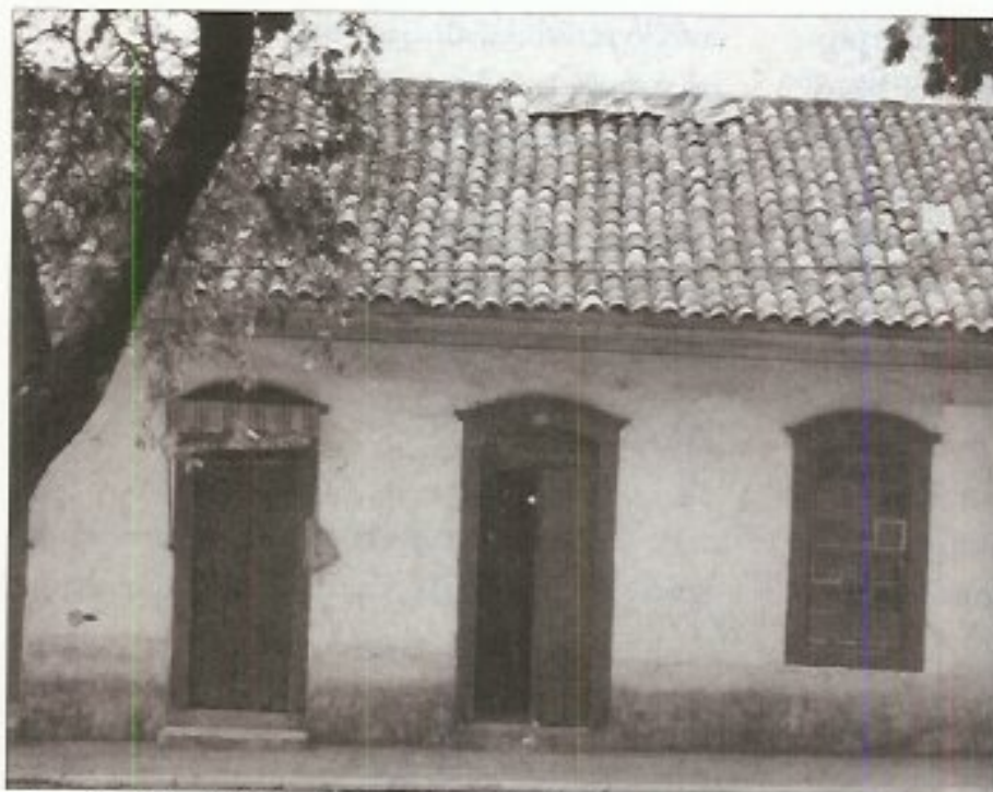
Casa localizada à Rua Coronel José Inácio, 83, no Centro de Jarinu - SP
