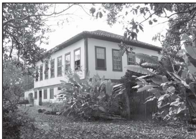
Fig. 24 - Sistema de gaiolas de madeiras, casa da Fazenda Nova, Mococa, SP. Foto do autor.
