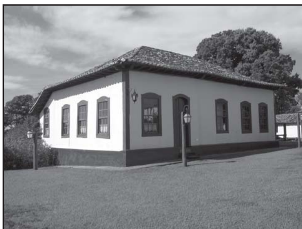
Fig. 25 - Estrutura de madeira na casa da Fazenda São José, Nuporanga, SP. Foto do autor.
