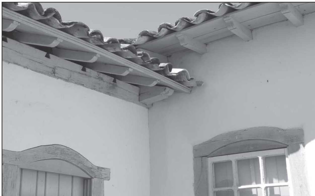
Fig. 17 - Detalhe de guarda-pó, casa da Fazenda São Miguel, Ritópolis, MG. Foto do autor.
