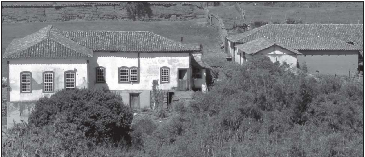
Fig. 23 - Telhados. Fazenda Capão Seco, Lagoa Dourada, MG. Foto do autor.
