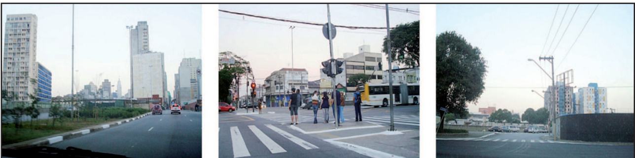
FIGURA 6 - Áreas próximas à Av. Tiradentes. É possível verificar na foto do centro, a grande distância que implica a travessia de um lado ao outro da via, onde não há calçadas nos pontos intermediários, apenas a pintura das faixas. O canteiro central, na foto à esquerda, apesar de ter uma calçada, não permite a travessia, pois tem uma cerca na extremidade oposta. À direita, a Rua Ribeiro de Lima em direção à Av. Tiradentes, onde se pode constatar a sequência de obstáculos interpostos aos pedestres. Fonte: Elaboração própria, 2011.
