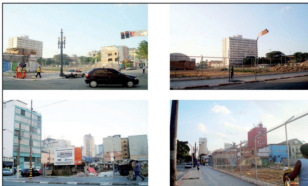
FIGURA 1 - Quatro imagens das demolições realizadas este ano na área da Luz, tomadas da Av. Duque de Caxias, uma das vias que definem o perímetro do Projeto Nova Luz. Fonte: elaboração própria, 2011.
