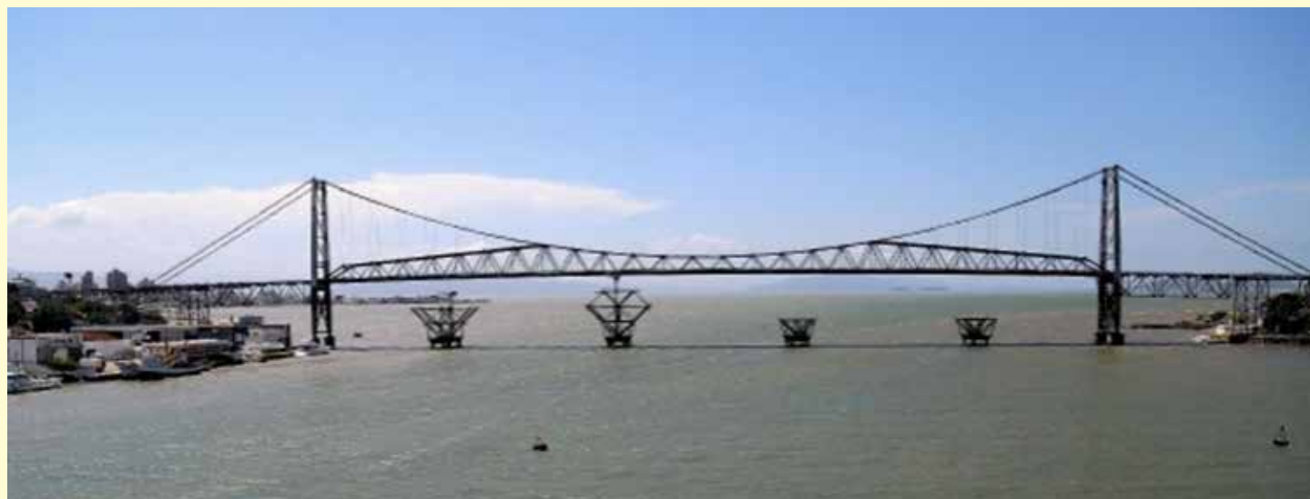
Imagem 4 – A Ponte Hercílio Luz em reforma (2015).
