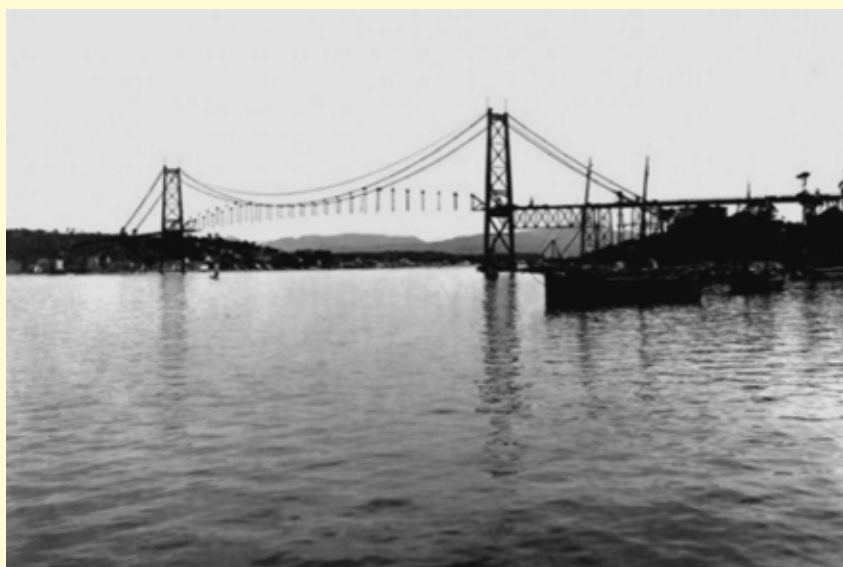
Imagem 1- Ponte Hercílio Luz em construção (1924).
