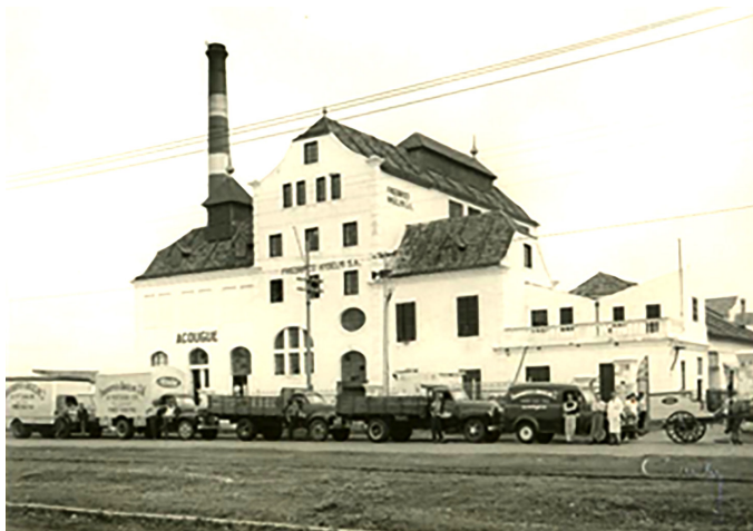
Figura 1 – Frigorífico Anselmi (s/d). Fotografia feita por Cauby.
