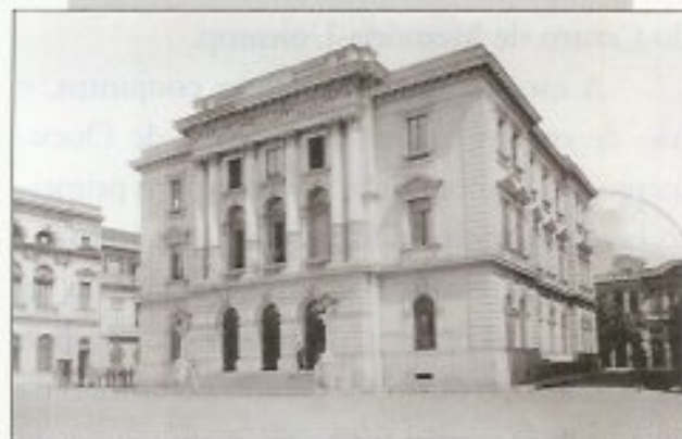
Edifício da Secretaria da Agricultura. São Paulo, SP, entre 1900 e 1905.
