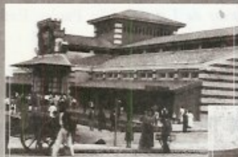
Estação Carlos Botelho
