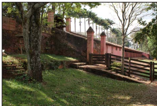
Portão principal de acesso a casa sede, com destaque para o muro de pedra e os pilares
