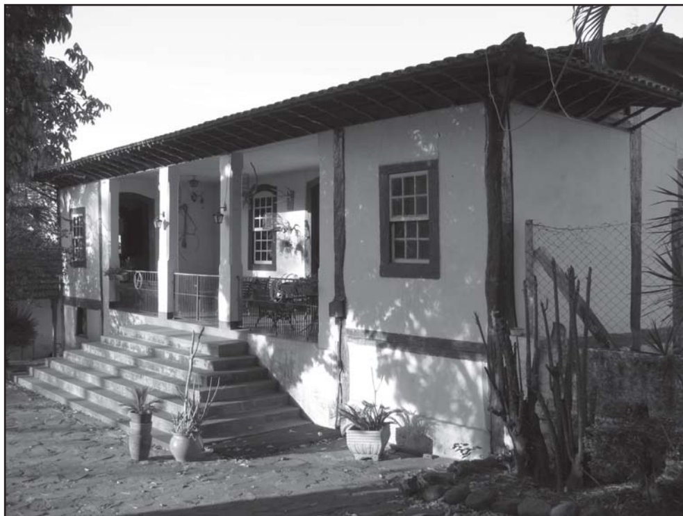
Fig. 29a - Fachada da casa da Fazenda Cachoeira, Casa Branca, SP. Foto do autor.
