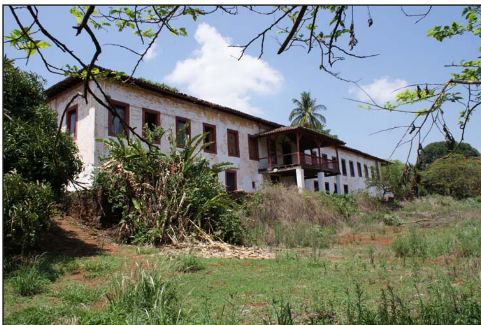
Fachada da casa sede, em destaque o alpendre fronteiroço
