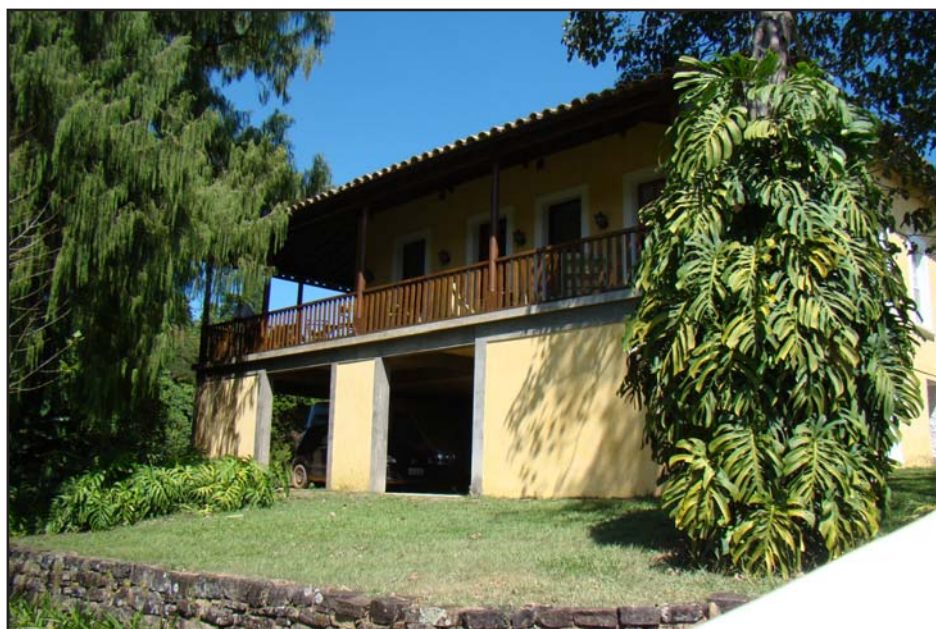
Fachada lateral da casa sede, com destaque para o alpendre assobradado
