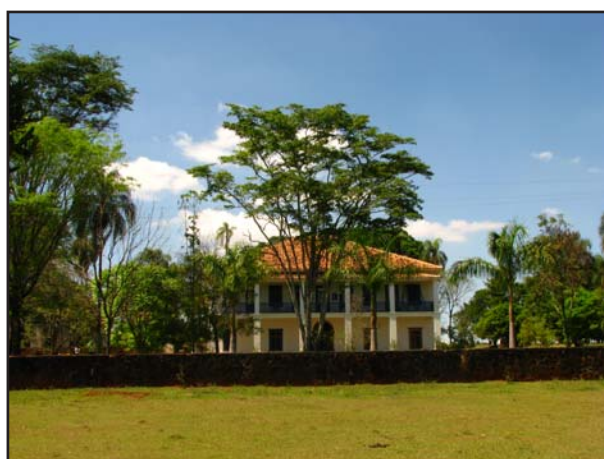
Fachada da casa sede
