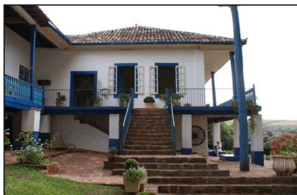
Fachada posterior da casa sede
