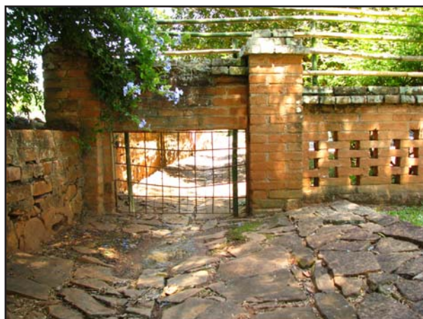
Muro da de contorno da casa sede; em destaque o calçamento em pedra
