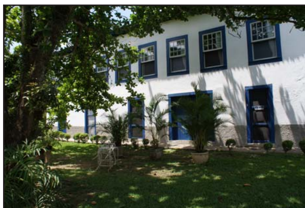
Fachada lateral da casa sede
