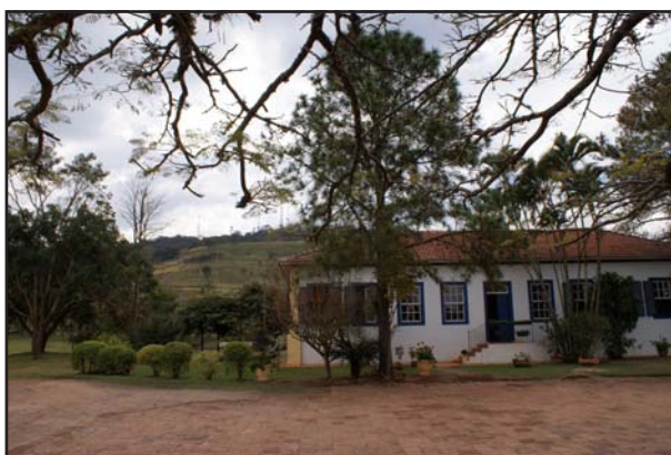
Fachada da casa sede
