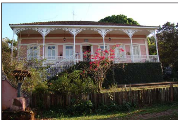
Fachada da casa sede, com alpendre frontal que possui lambrequis em seu beiral
