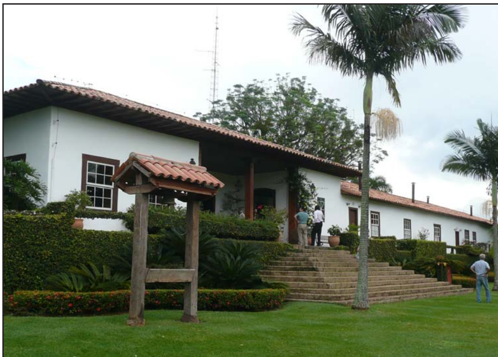
Fachada da casa sede
