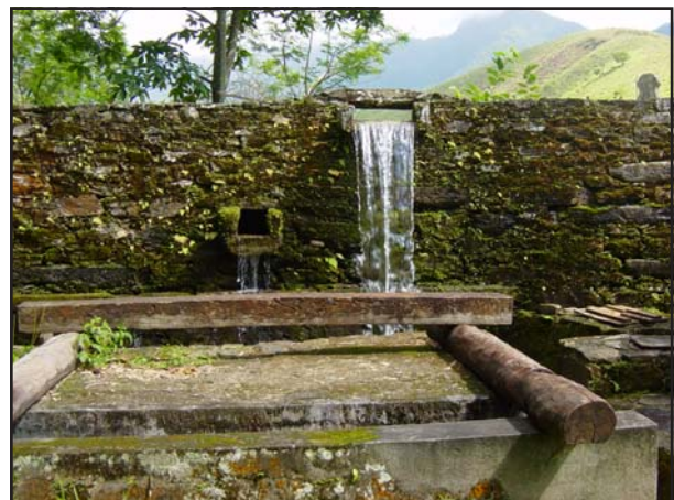
Escoamento de água para o tanque de lavagem de café
