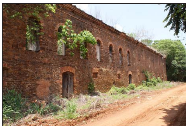
Fachada lateral da tulha
