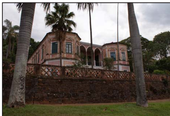
Fachada da casa sede, em destaque o muro de pedra
