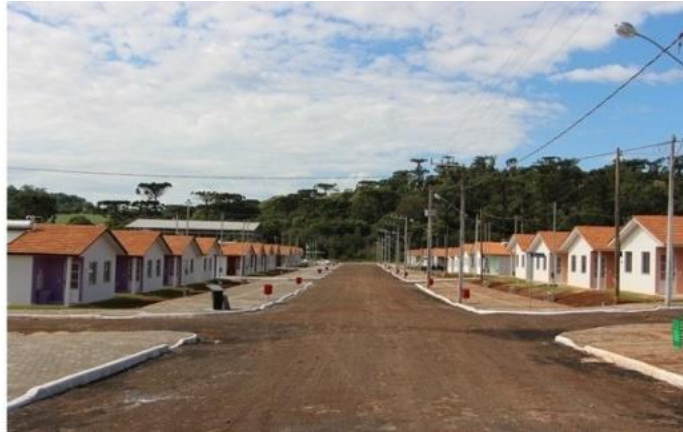
Conjunto Habitacional Vida Nova - São Domingos/SC Fonte: Prefeitura Municipal de São Domingos-SC (2014).
