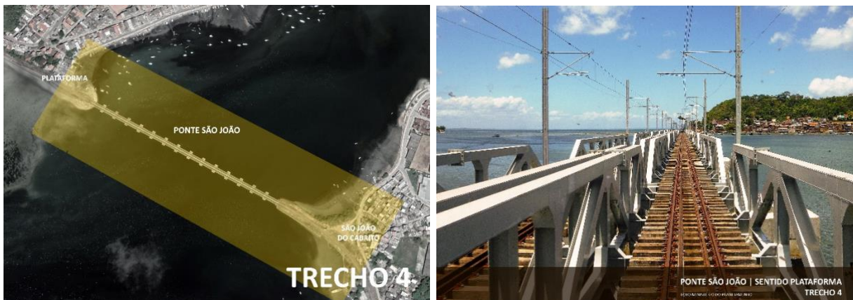
Figs.08 e 09 - Trecho 04, Ponte São João. Imagens de base Google, 2020.
