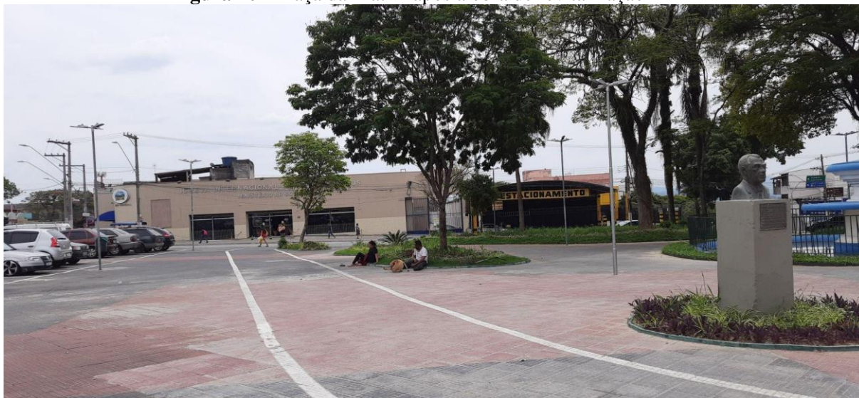
Figura 10 - Praça da Matriz após a obra de revitalização
