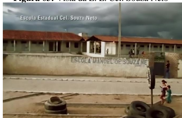
Figura 03: Vista da E. E. Cel. Souza Neto
