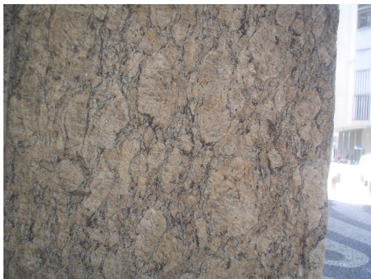
Figura 16. Detalhe de gnaiss facoidal em cantaria da fachada da Igreja da Candelária.
