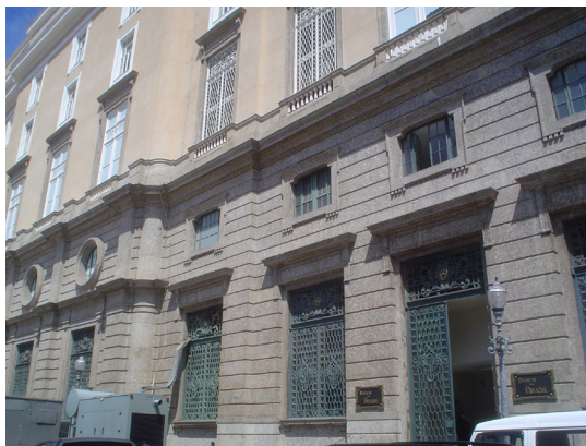
Figura 24. Fachada em gnaiss facoidal do Centro Cultural dos Correios na região da Candelária
