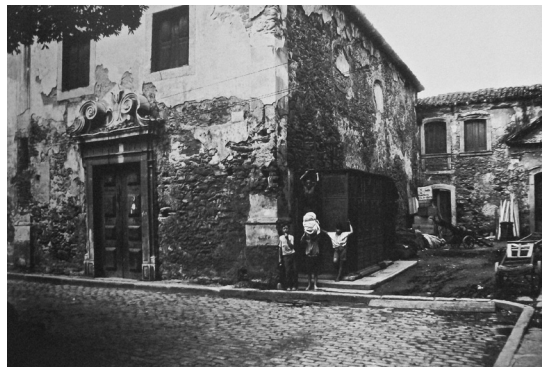
Figura 1. Igreja de São Domingos, situada no largo do mesmo nome, em 1928. Construída em 1791, foi demolida para abertura da Av. Presidente Vargas. Situava-se defronte à atual Av. Passos. Foto de Augusto Malta, extraída de Ermakoff (2009)
