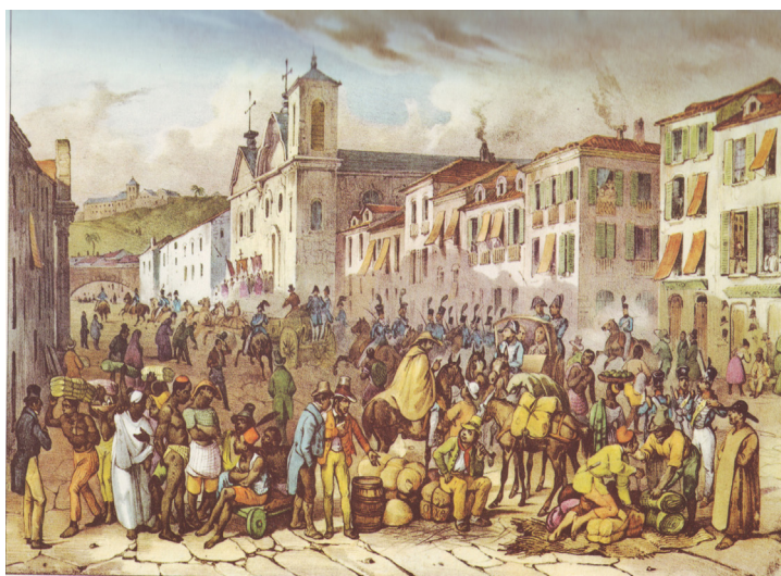
Figura 3. Aspecto da Rua Direita, atual Primeira de Março, em pintura de Rugendas (1889). Em primeiro plano, destaca-se o pavimento, cuja qualidade era comparada às ruas mais bem pavimentadas de Londres. À esquerda, ao fundo, o Morro do Castelo, derrubado durante a gestão do prefeito Pereira Passos. Destaque para a Igreja do Carmo, também ilustrada na figura 2
