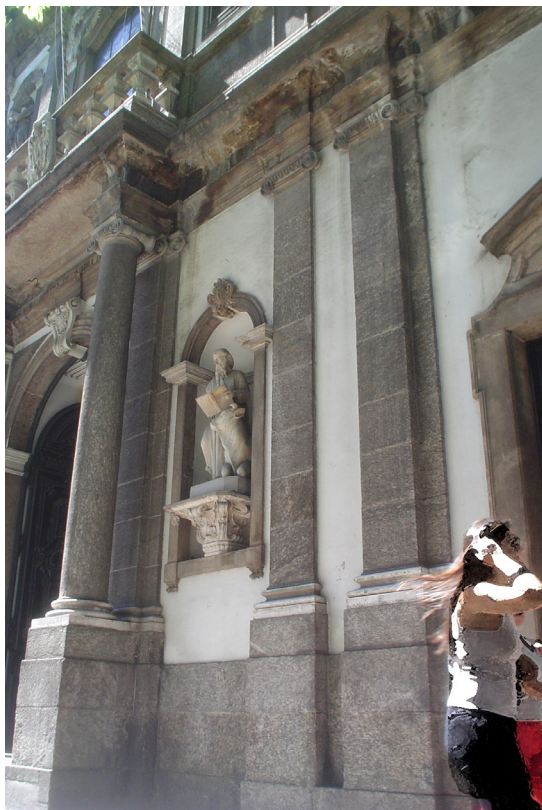
Figura 26. Igreja Santa Cruz dos Militares, na Rua Primeiro de Março, edifício histórico que data do século XVII. Foi reformada durante os séculos XVIII e XIX, ornada com gnaiss facoidal
