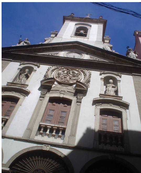
Figura 25. A Igreja Nossa Senhora da Lapa dos Pescadores, na região da Candelária, ornada com cantarias de gnaiss facoidal. Foi erguida no século XVIII e reformada no século XIX
