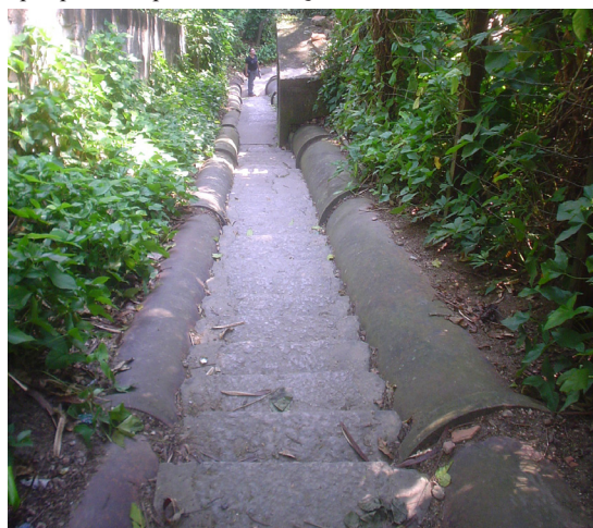
Figura 32. Escadaria estruturada em gnaiss facoidal para acesso ao Reservatório do Morro da Viúva. Acesso pela Travessa Acaraí
