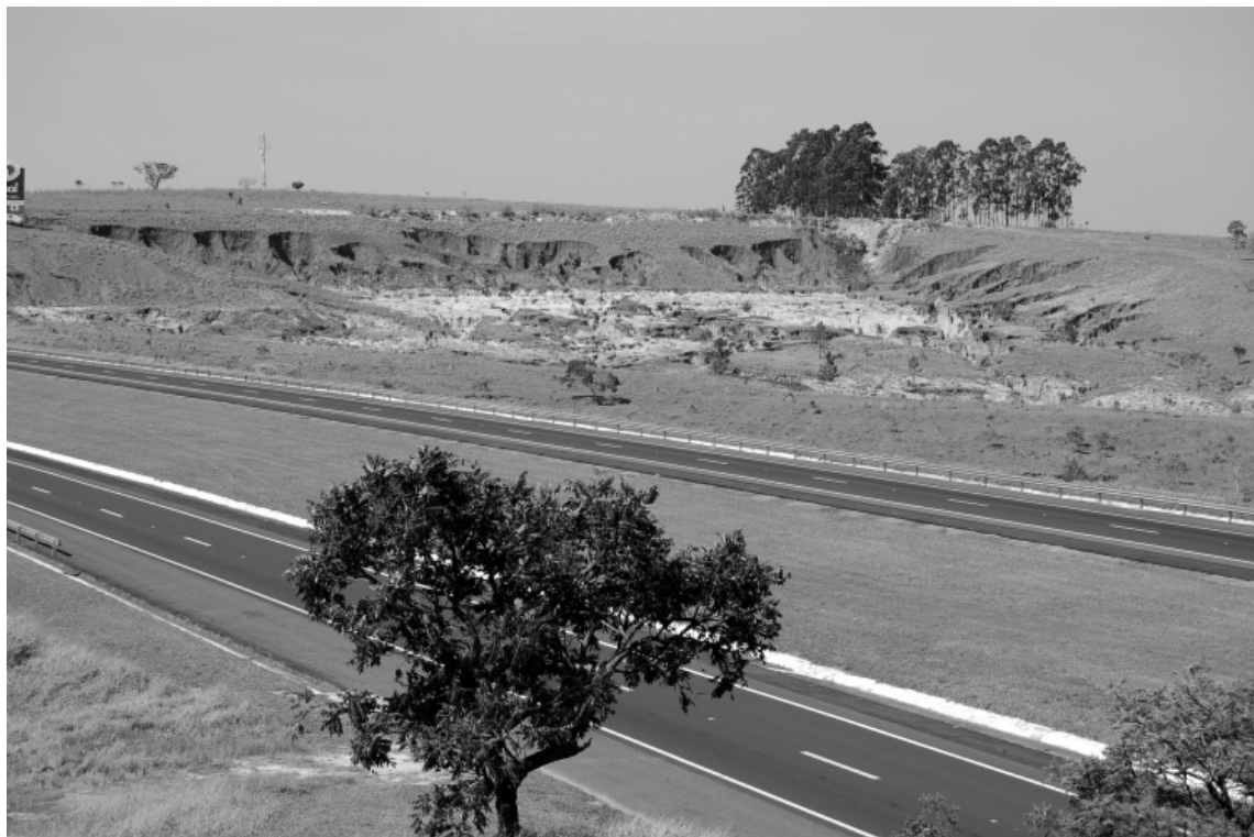
Figura 20 – Boçoroca próxima ao ponto C2. Observe que a erosão atinge até mesmo os solos vermelhos da parte superior da zona terraplenada (mais clara) que correspondem a solos superficiais, geralmente mais resistentes à erosão
