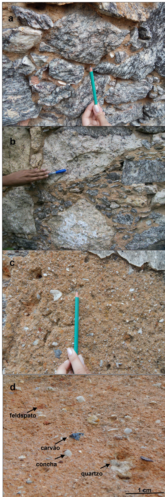
Figura 3. Argamassa em alvenaria de pedra das Ruínas do Matadouro: a,b) Argamassa de assentamento; c,d) argamassa de emboço. Foto dos autores. 2016
