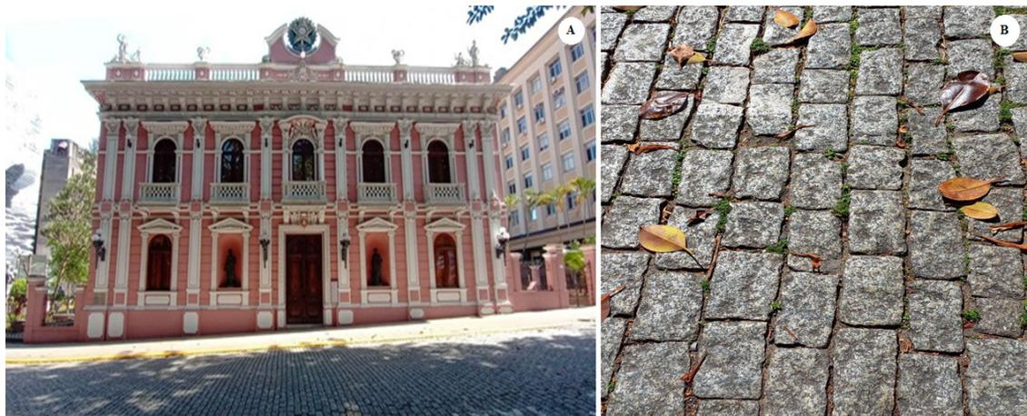
Figura 2. Pavimentação em granito da Rua Alcipeste Paiva em frente ao Palácio Cruz e Souza (A), detalhe dos granitos talhados em paralelepípedos (B). Fonte: Arquivo pessoal dos autores
