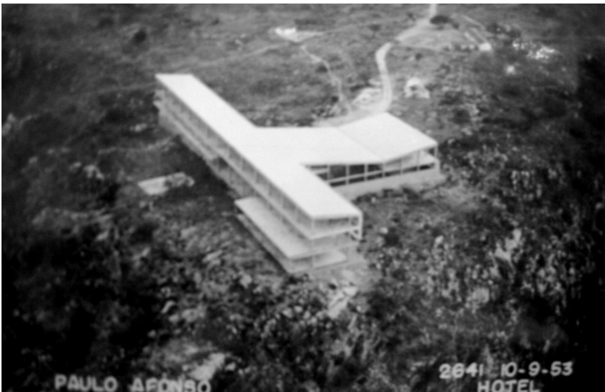
Figura 07: Vista aérea do Hotel Paulo Afonso, já com todo o esqueleto de concreto erguido, em 10 de setembro de 1953.
