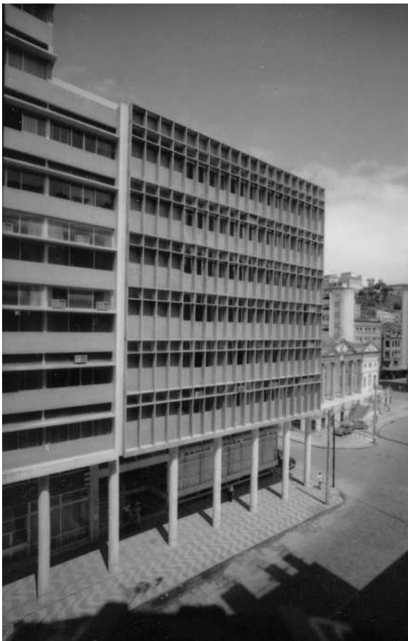
Figura 05: Edifícios construídos no bairro do Comércio entre o final dos anos 1950 e início dos 1960: blocos sobre pilotis, com criação de galerias cobertas, de acordo com as diretrizes do EPUCS e a legislação urbana delas decorrente – à esquerda, Edifício Ouro Preto, à direita, Edifício Almirante Barroso, ambos projetados por Diógenes Rebouças.
