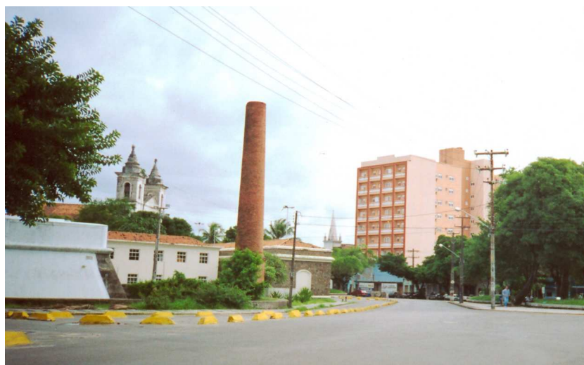
Figura 3. Edifício São José, reabilitado com recursos do PAR (foto: Cláudia Loureiro, 2004)
