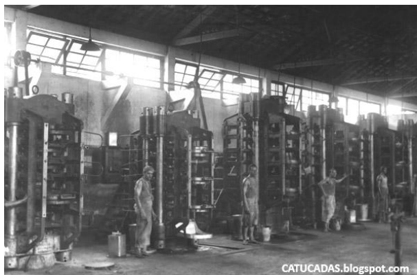
Figura 03 – Vista do interior da Fábrica Kaufmann em funcionamento, em 1942
