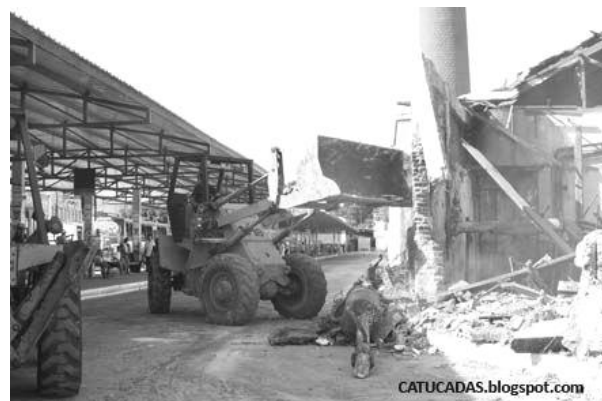
Figura 04 – Demolição da Fábrica Kaufmann em 25/05/2008
