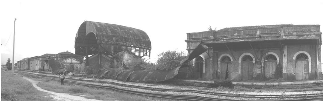
Figura 06 – Vista geral da Estação São Francisco em Alagoinhas (foto realizada pelo autor, 09/04/2008)
