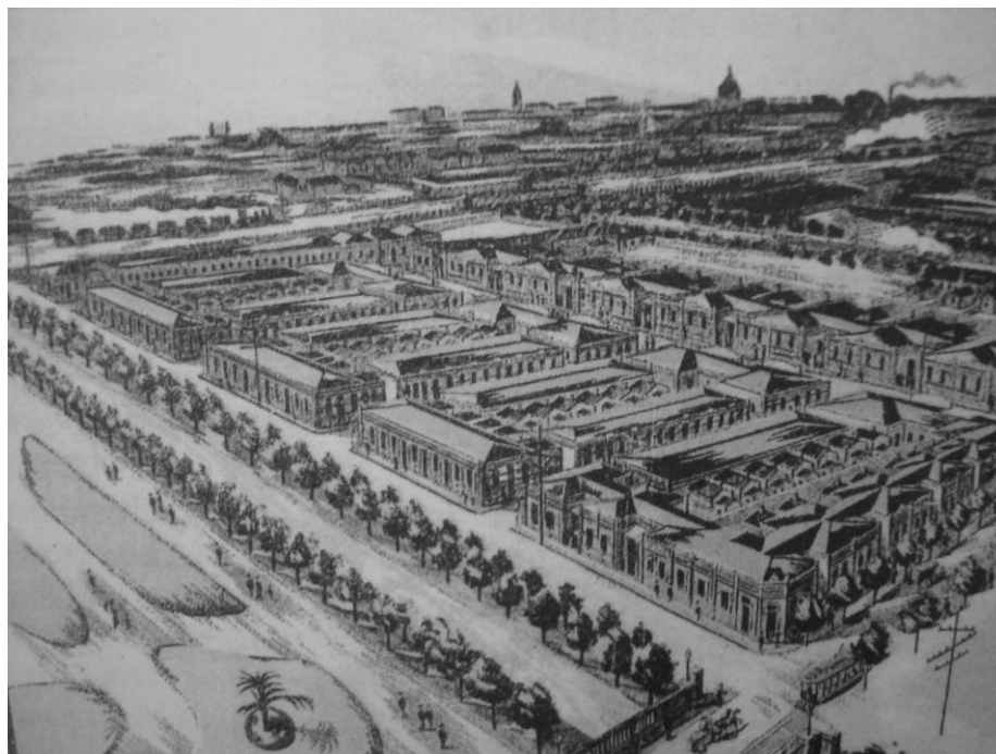
Figura 11: Vista da vila implantada no bairro da Luz – Vila Particular Economizadora Paulista. Fonte: BONDUKI, Nabil. Origens da Habitação Social no Brasil . p.66.
